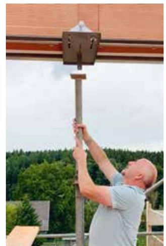
Arretierungszapfen an der Stahlstütze einstecken. Stütze ausrichten – FERTIG!
